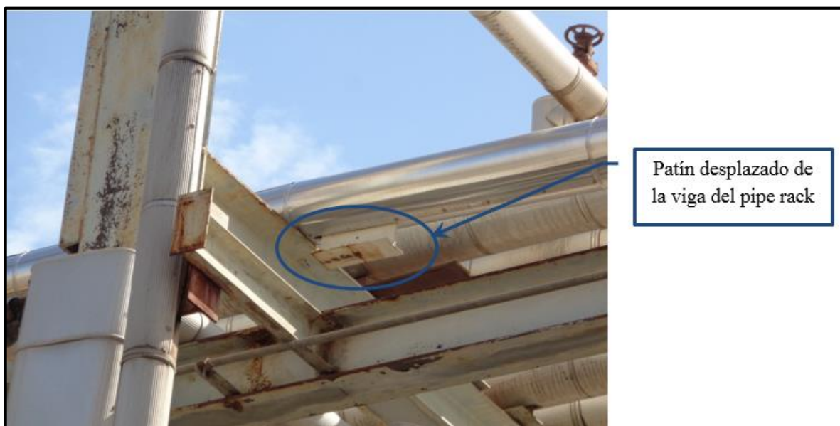
Figura 11: Detalle del desplazamiento de los patines fuera de la viga de apoyo
