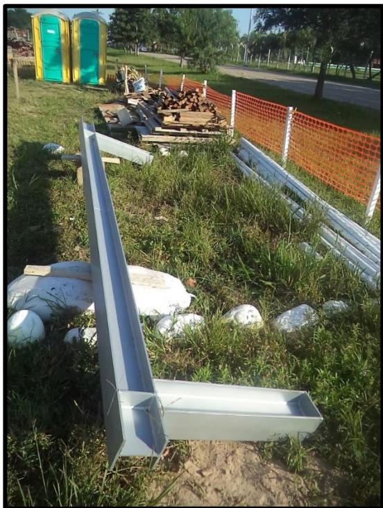
Figura 2: Soporte tipo pórtico. SP-05 y SP-06 de la lista de soportes
